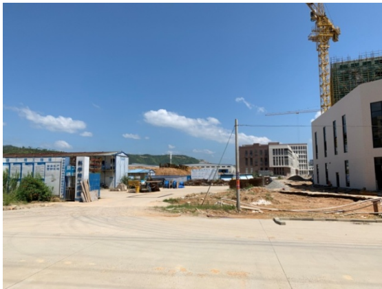
项目北面工业厂房（在建）
