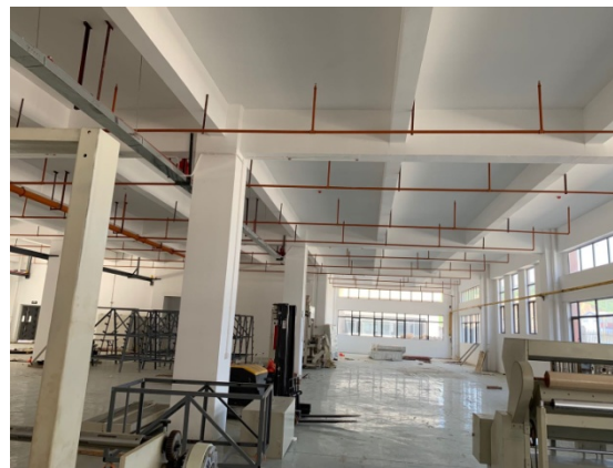
项目一楼车间现状
