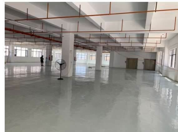
项目二楼车间现状
