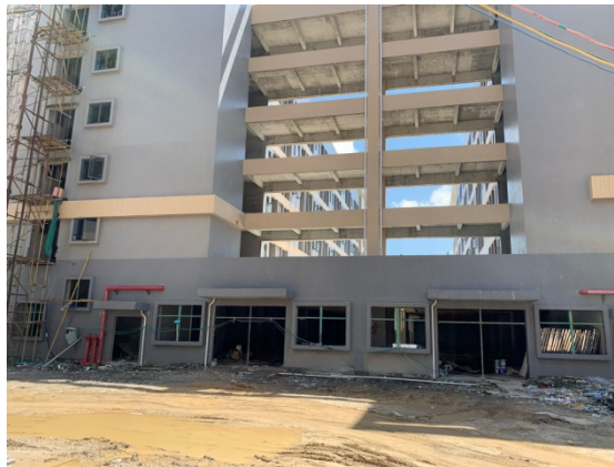
项目东面员工宿舍（在建）
