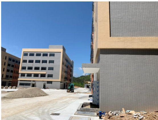
项目西面工业厂房
