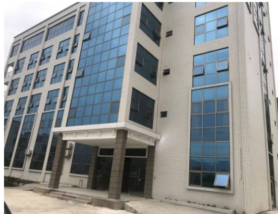
项目医院大楼
