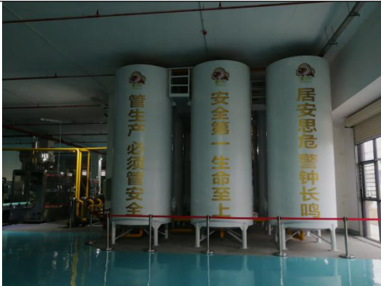
基础油储油罐
