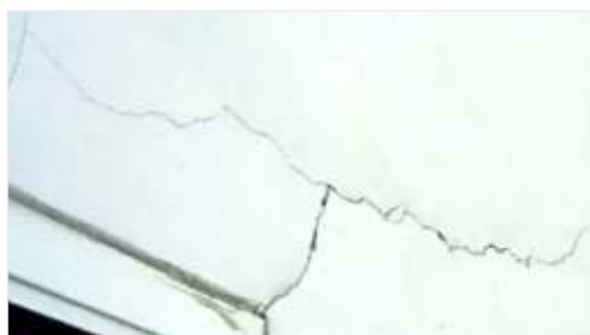
现象:墙体仅门窗洞口角部有少量裂缝 判断:不属于安全隐患
