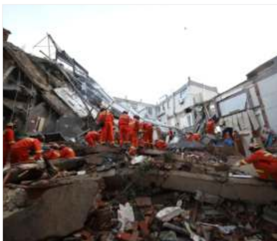
2020年8月29日, 山西省襄汾县聚仙酒家倒塌; 事故原因为违法违规占地建设, 且在无专业设计、无资质施工的情形下, 多次盲目改造扩建
