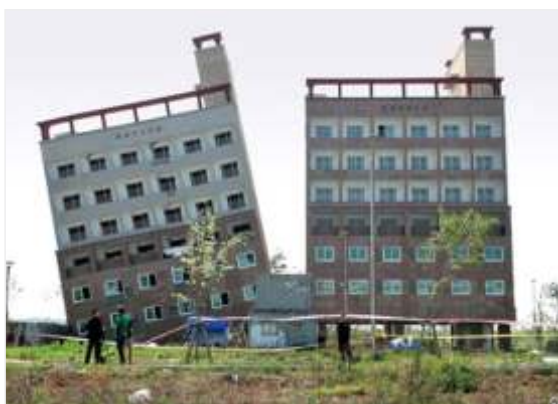
沉降不均匀引起房屋倾斜
