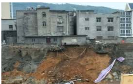
临近未支护的基坑
