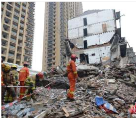
2016年10月10日, 浙江省温州市鹿城区民房倒塌; 事故原因为该自建房年代久、质量差, 地质基础不牢
