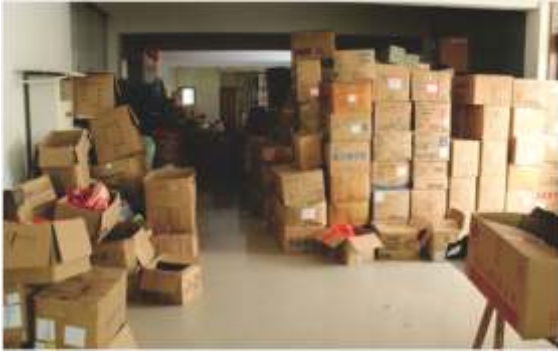
住宅改作仓库、楼面超载
