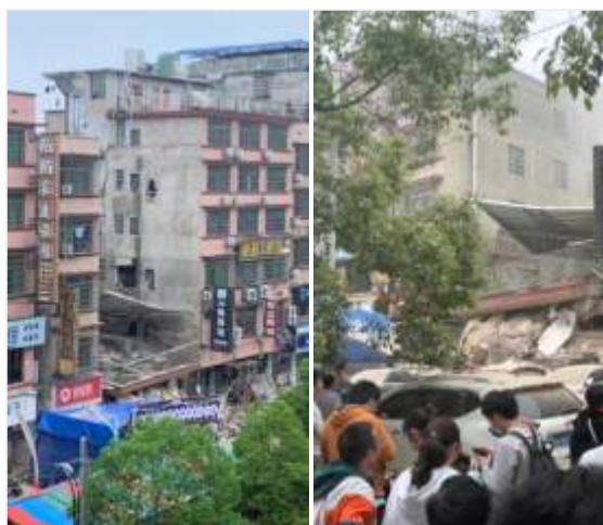
2022年4月29日, 湖南省长沙市某楼房倒塌; 该房屋倒塌前存在加层扩建、具虚假房屋安全鉴定报告等行为, 事故详细原因在进一步调查中
